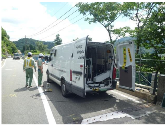
写真-1 調査対象橋梁
