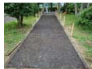
(e)敷きならし施工完了
