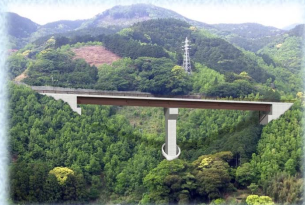
国道136号土肥拡幅工事
