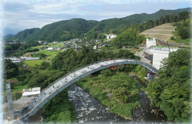
狩野川横断高架橋（国土交通省提供）
