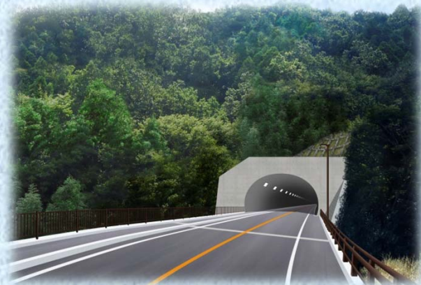
国道136号下船原バイパス工事
