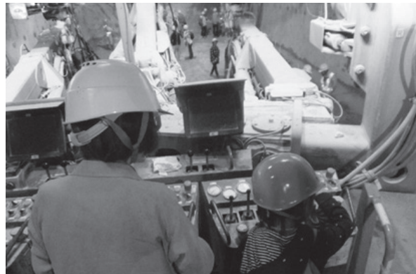
●切羽・重機試乗状況
