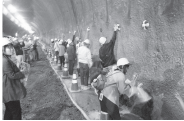
●防水キャップ取付け
