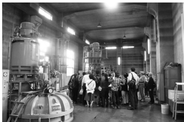
●松重ポンプ所での説明
