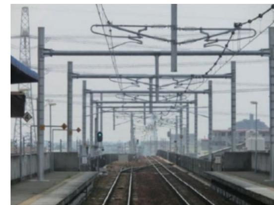
図1 鋼管ビームを用いた門型構造【東海旅客鉄道株】
