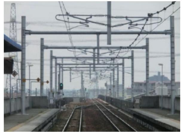
図1 鋼管ビームを用いた門型構造【東海旅客鉄道株】
