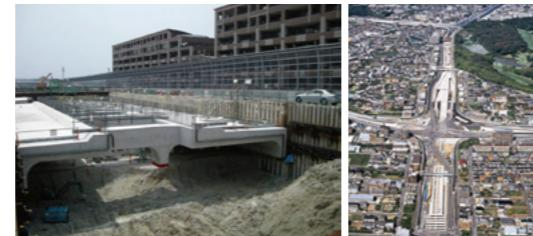
仮設遮音壁と逆巻き工法
