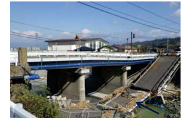
(一) 内村川 (一) 荻窪丸子線 上田市 内村橋
