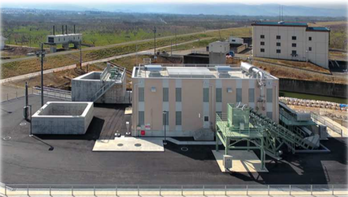
浅川第三排水機場
