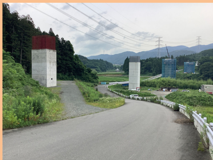
東海環状自動車道(田切川橋)
