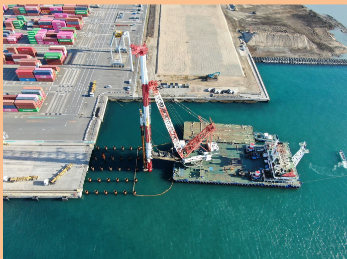
四日市港霞ヶ浦北ふ頭地区岸壁
