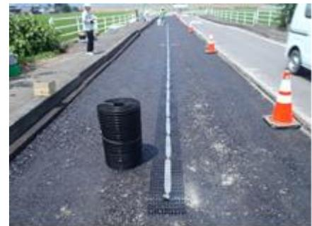
図-4 光ファイバ内臓センサーの敷設状況
