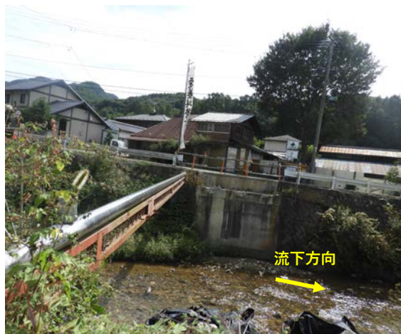
写真-4 撤去された宮浦橋上部工
