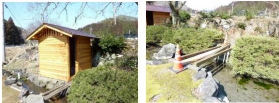
(a)改修中の水車小屋 (b)橋の設置準備 写真-2 改修工事 (2022.2/26 撮影)
