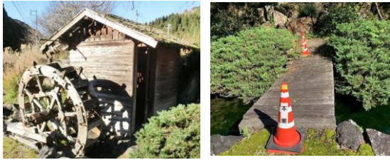
(a)水車小屋 (b)壊れた橋 写真-1 本巢市湯ノ古公園
